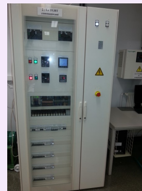
T.G.B.T : Tableau Général Basse Tension
