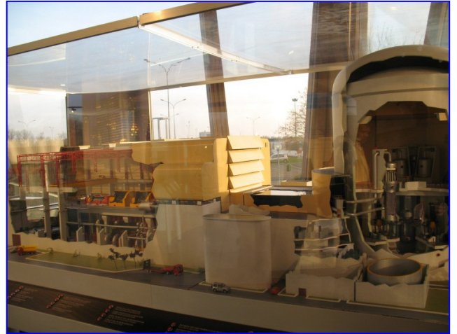
On aperçoit la salle des machines à gauche, le bâtiment du réacteur sur la droite de la photo.
